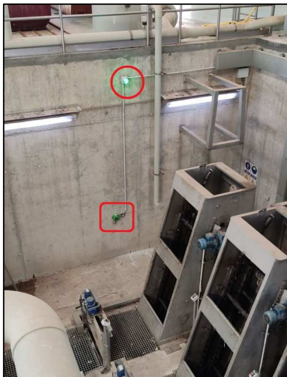
Detectores y avisadores instalados en el sótano de rejillas del pretratamiento
