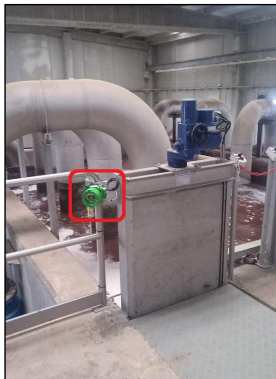
Detectores instalados en la zona de tamices de finos del pretratamiento
