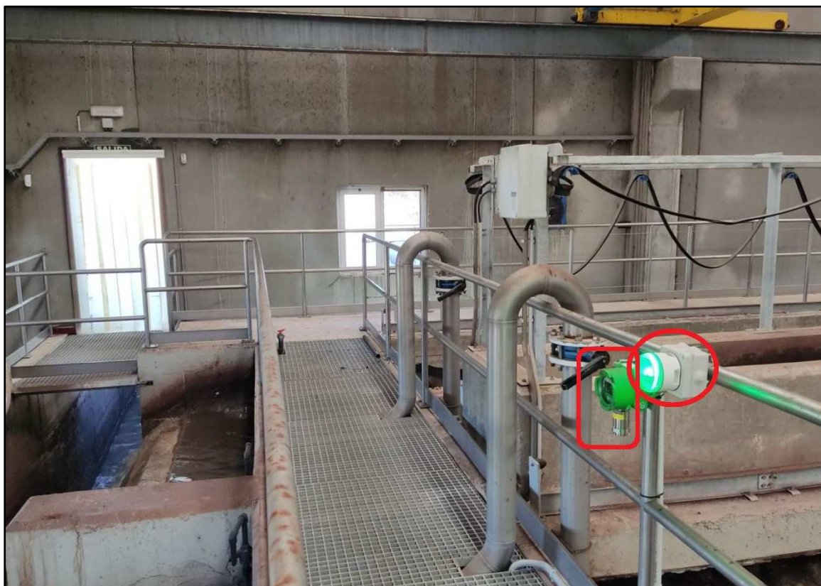
Detector y avisador instalado en la zona de salida de los canales desarenadores
