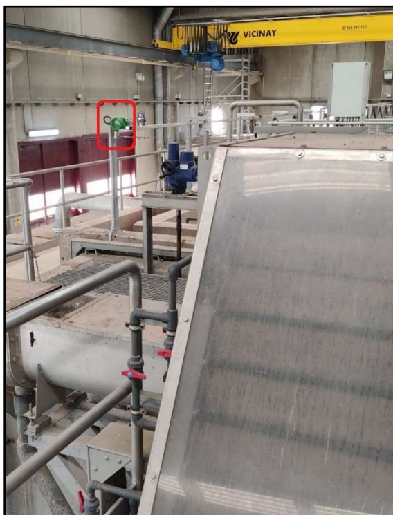
Detectores instalados en la zona de tamices de finos del pretratamiento
