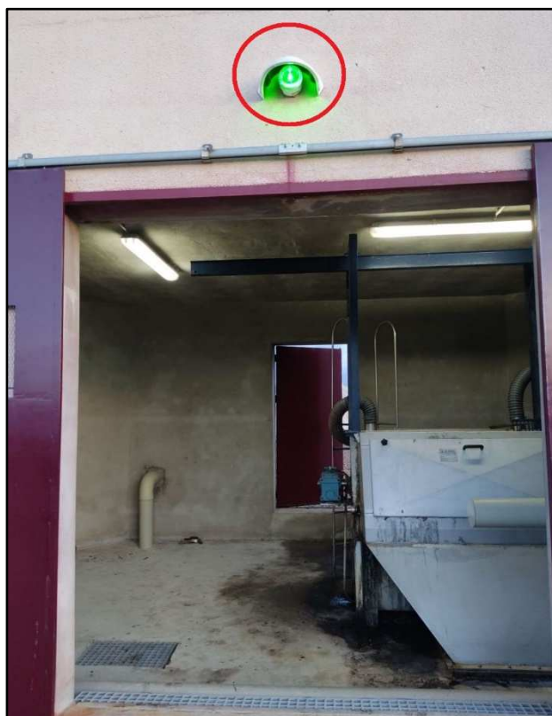
Detector y avisador instalado en la sala del tamiz de fangos primarios del edificio de fangos.
