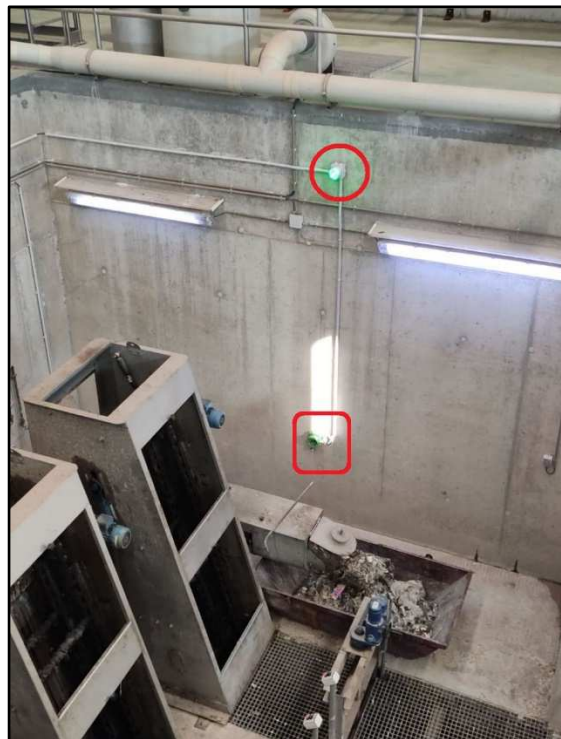
Detectores y avisadores instalados en el sótano de rejillas del pretratamiento
