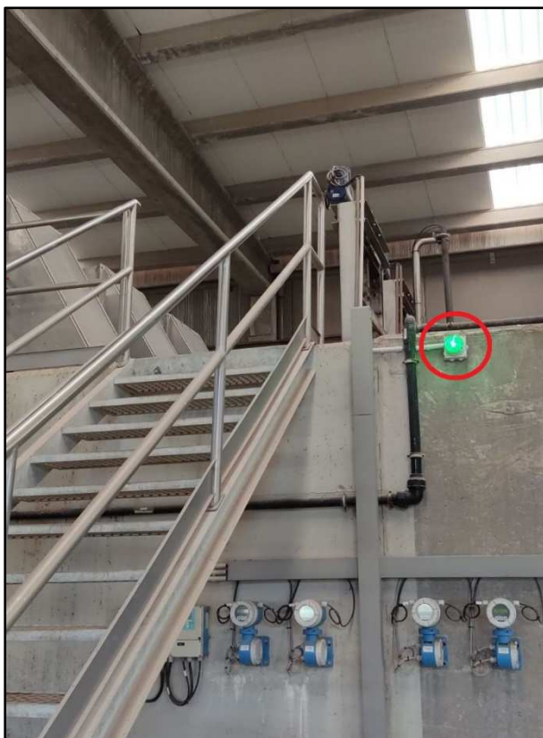
Avisador correspondiente a la zona de tamices instalado en la escalera de acceso al área de trabajo
